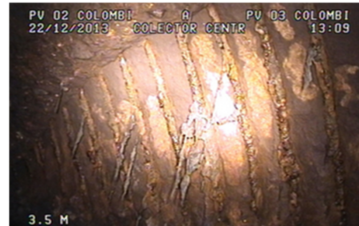
Ausencia de acero de refuerzo
