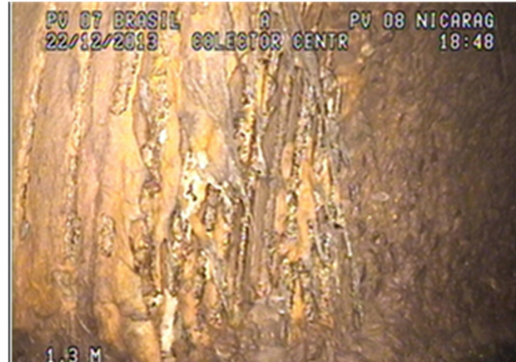
Acero de refuerzo expuesto en tubo
