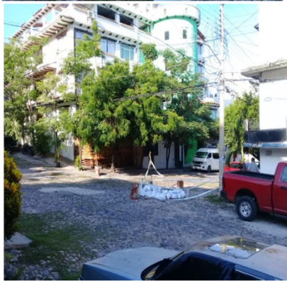
Colapso CCN, calle Brasil esq. Panamá Col. 5 de Diciembre (Agos.2018)
